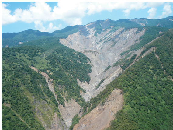
▲照片4 集水區上游林班地之崩塌情形。
