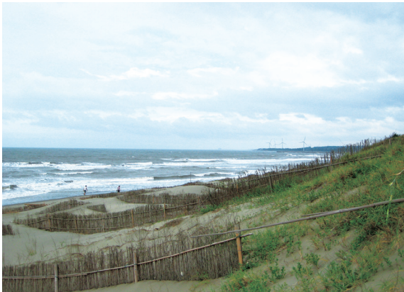
▲竹南沿岸面臨海岸線後退的危機，居民架上竹籬想辦法固砂。
