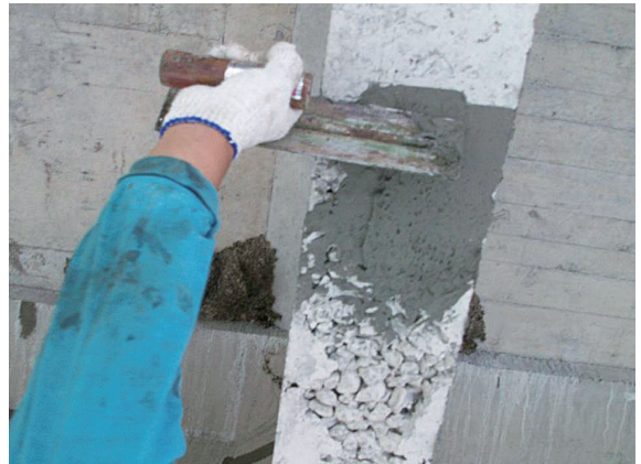
▲照片8 蜂窩處理施工前。
