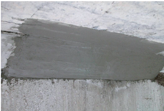
▲照片7 鋼筋銹蝕外露補強竣工。
