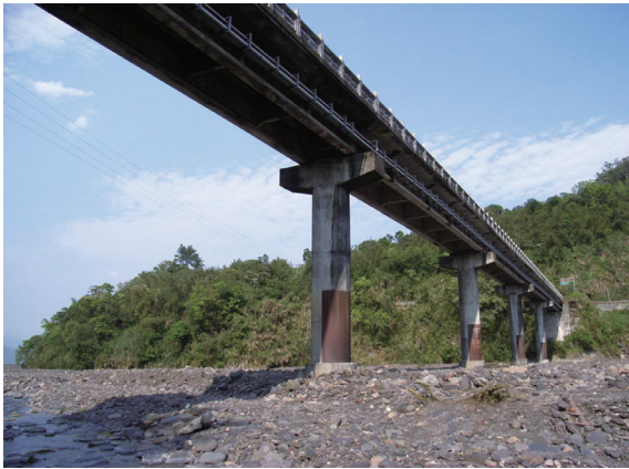
▲照片2 鋼板補強施工前。
