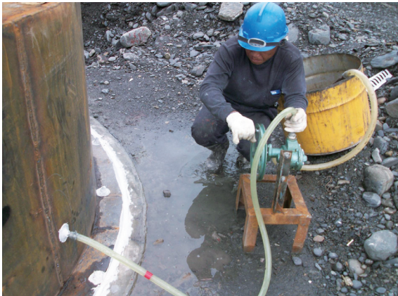
▲照片10 利用環氧樹脂填充作鋼板補強。
