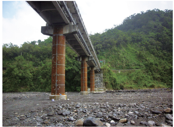
▲照片3 鋼板補強竣工。
