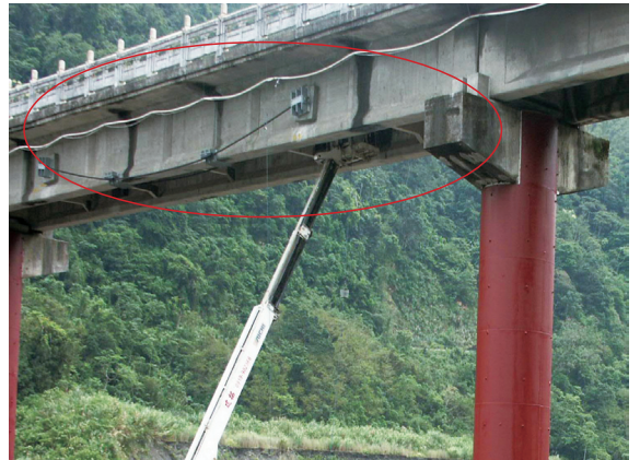
▲照片12 多望橋外加預力補強。
