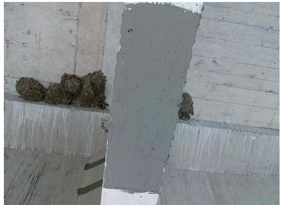
▲照片9 蜂窩處理竣工。
