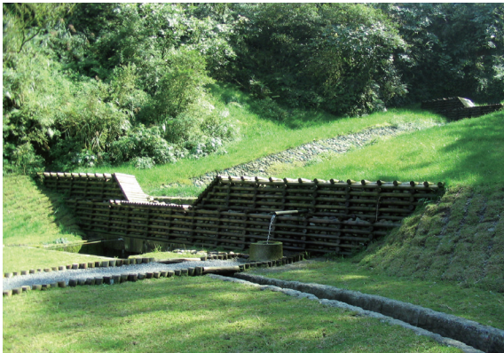
▲照片5 太平山專用道15.4 k旁木格框壩完工1年後情形。
