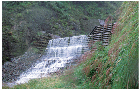
▲照片2 太平山國家森林遊樂區專用道23.9k旁木格框壩，豪大雨過後溢洪口溪水溢流情形。
