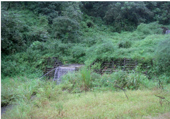
▲照片6 太平山專用道15.4 k旁木格框壩完工4年後情形。
