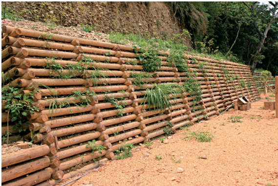
▲照片2 木製校倉式擋土牆。(攝影/張為傑)
