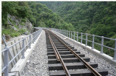
32 橋梁枕木鋼軌及欄杆鋪設
