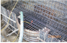
19 橋梁帽樑混凝土澆置
