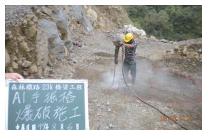
1 基樁位置放樣爆破鑽孔炸藥放置
