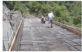
26 橋面板鋼筋模板完成
