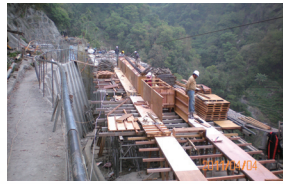
24 橋面板鋼筋模板組立
