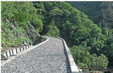
31 橋梁道碴鋪設
