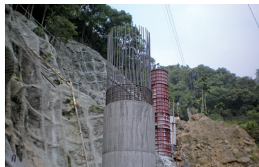
16 橋梁橋墩鋼模折模
