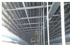
11 基樁完整性試驗PVC管
