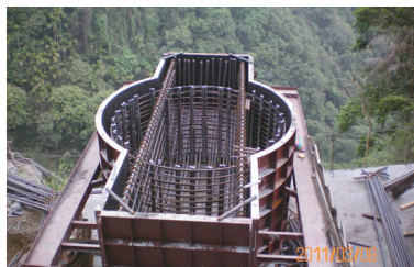
18 帽梁鋼筋鋼模組立
