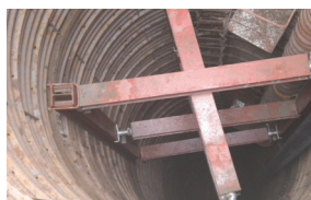
6 基樁十字型支撐安裝
