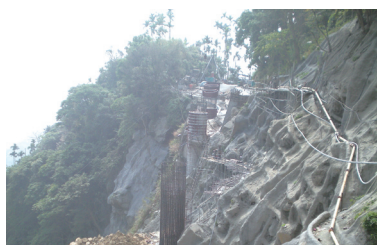
15 橋墩鋼筋鋼模組立
