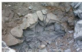
3 基樁爆破開挖
