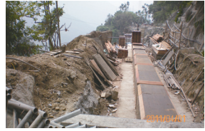
22 橋面板模板組立
