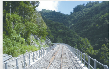
33 鐵路橋梁完成
