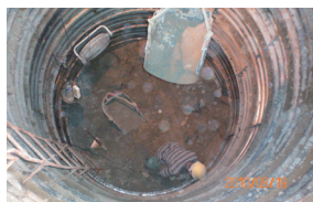
4 基樁人工開挖鋼襯板組立
