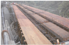
23 橋面板模板組立
