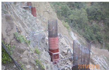
17 橋墩混凝土澆置
