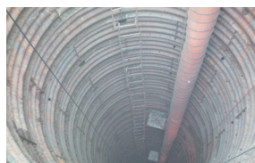
7 基樁內通風及安全措施
