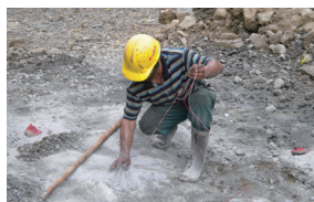
2 基樁位置爆破鑽孔炸藥放置
