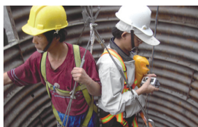
8 嘉義林區管理處楊處長(現為林務局副局長)基樁深度視查
