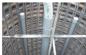
12 基樁混凝土澆置
