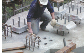
20 盤式支撐安裝
