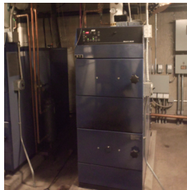
圖13 該中心具有3部以木材顆粒為能源的生質能源裝置，主要提供暖氣空調使用。
