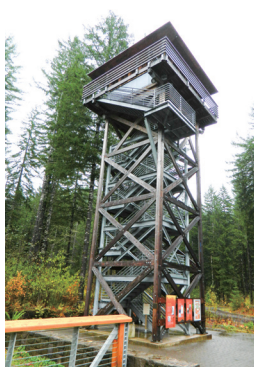
圖7 約12公尺高的觀火高塔，一般都設置在山區的制高點，可以監測森林火災。
