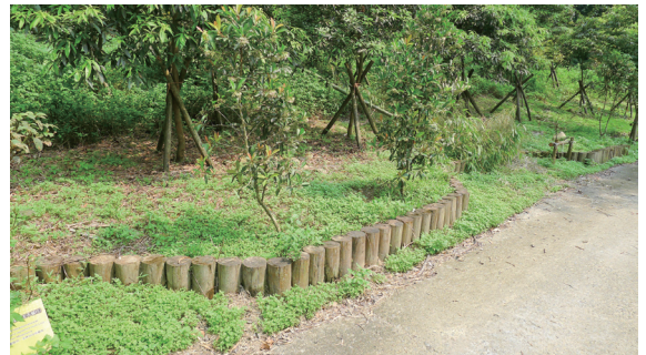
圖7 木製擋土柵(二)：單元高度較小，常用於崩塌坡面之階段式擋土措施，坡度較陡地區，需以鐵線背拉固定。
