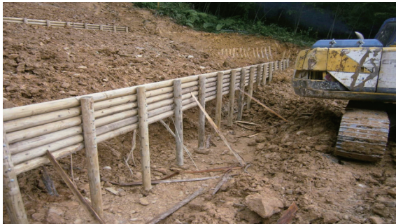
圖7 木製擋土柵(二)：單元高度較小，常用於崩塌坡面之階段式擋土措施，坡度較陡地區，需以鐵線背拉固定。
