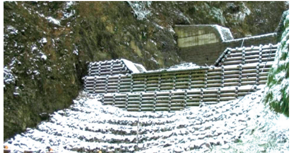
圖12 木格框節制壩(96年，宜專一線23.9K)
