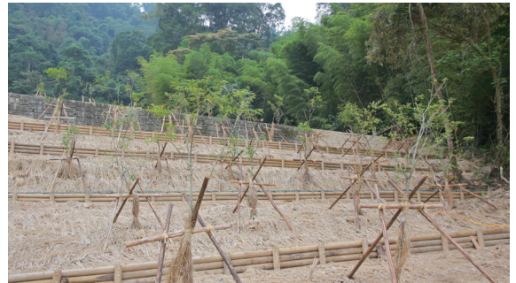
圖7 木製擋土柵(二)：單元高度較小，常用於崩塌坡面之階段式擋土措施，坡度較陡地區，需以鐵線背拉固定。
