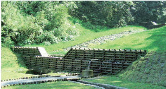
圖11 木格框節制壩(95年，宜專一線15.4K)
