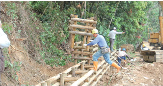
圖3 堆疊式格框擋土牆：單元組立疊置，可順應現地地形調整及現地樹木保留。
