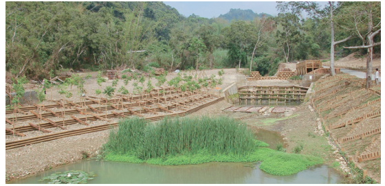
圖15 坑內坑野溪治理(99年)
