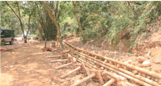
圖2 堆積式擋土牆：預先組合材料單元搬運方便，人工施工容易。
