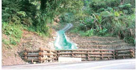
圖10 原木木格框擋土牆(92年，宜專一線)
