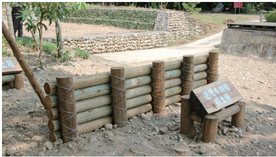
圖6 木製擋土柵(一)(苗木栽植)：屬階段式擋土柵，適合低矮及坡度較緩之邊坡。
