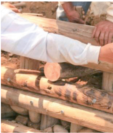
19. 施工坡度檢核
