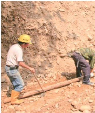
17. 鐵絲綁紮施工
