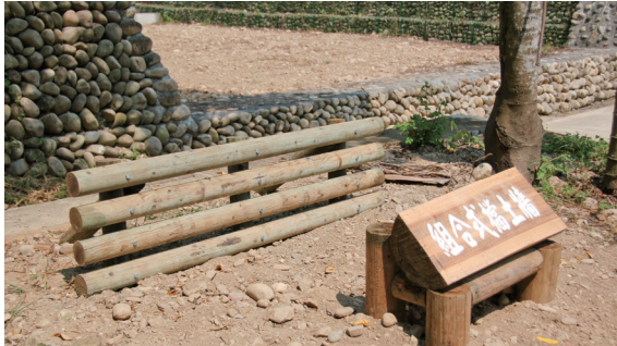
圖5 木製擋土柵(組合式)：單元組立，可分階段設置之擋土設施。
