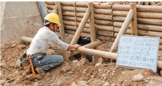
圖4 前撐式擋土牆：常用於鬆軟土方區之擋土措施，擋土方少，可分階構築。
