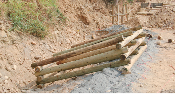
圖1 仿校倉式格框擋土牆：規格化加工圓木格框狀分層疊置，兼具多孔性與景觀美質。
