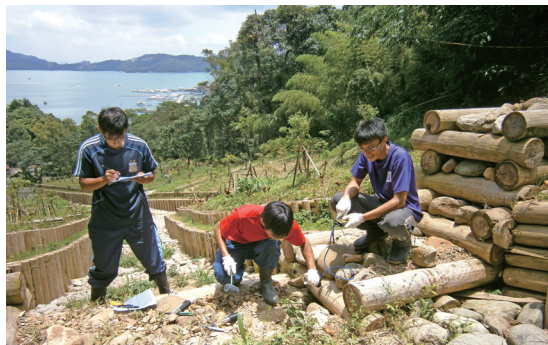
圖8 木構造物劣化、腐化檢測
