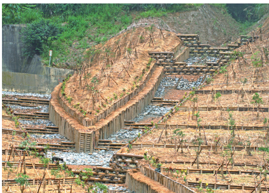
圖1 日月潭巒大區29林班坡面處理及坑內坑溝處理工程(南投縣魚池鄉)
