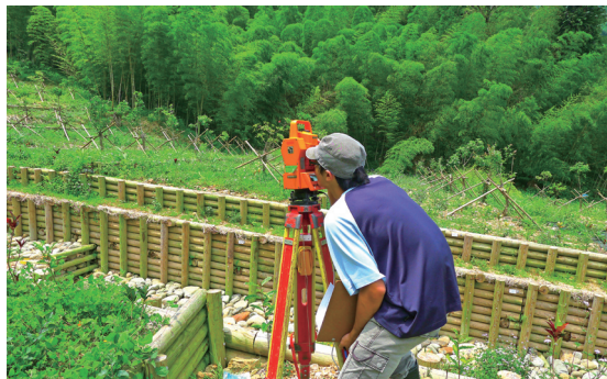
圖7 木構造物位移、變形安全檢測
