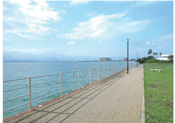
照片2 博多港水泥護岸隨處可見
