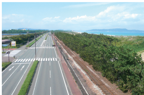
照片5 海岸防風林被道路及鐵路貫穿
