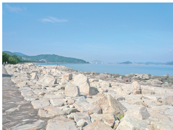
照片12 以自然塊石堆砌的護岸
