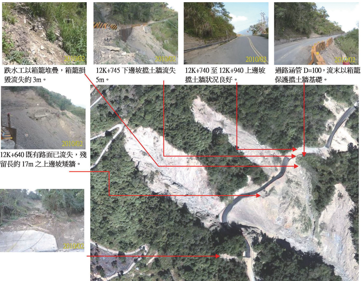
圖3 藤枝聯外道路12.6K寶山二號橋施工前之莫拉克風災狀況
