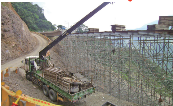
施工架搭設與橋面版鋼筋綁紮
