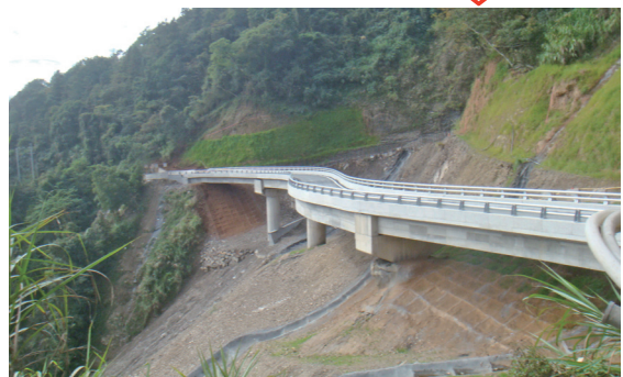
護欄與AC鋪面完成
