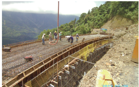
橋面版灌漿施工與混凝土養護
