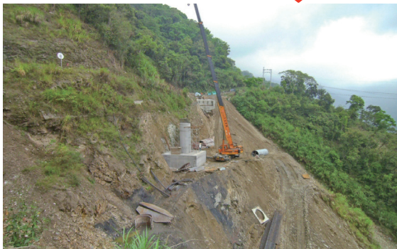
基樁帽樑與墩柱完成
