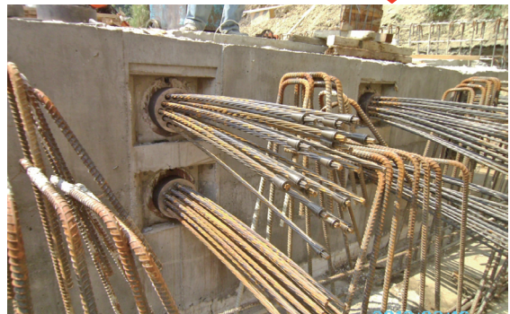
橋面版預力鋼絞線穿線與施加預力
