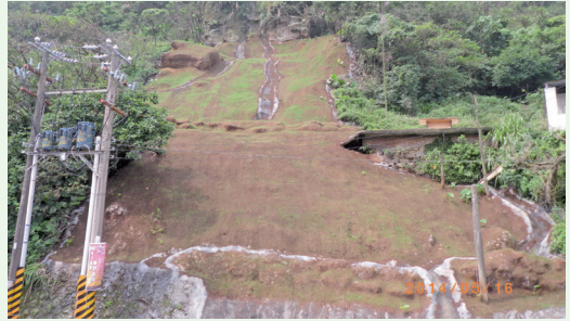
基隆北寧路，崩塌面植生完工。（攝影／羅東林區管理處 吳文欽）
