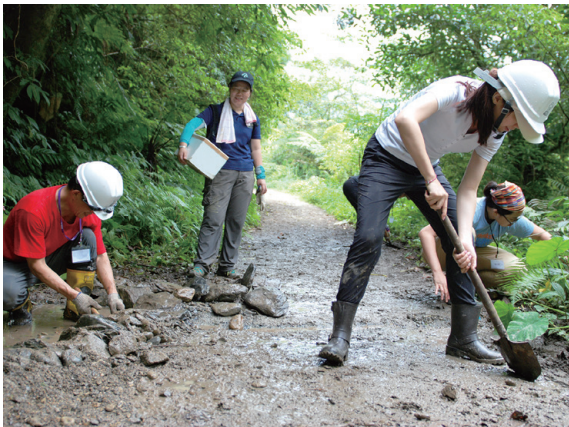
▲圖3、桶後越嶺步道泥濘處理
