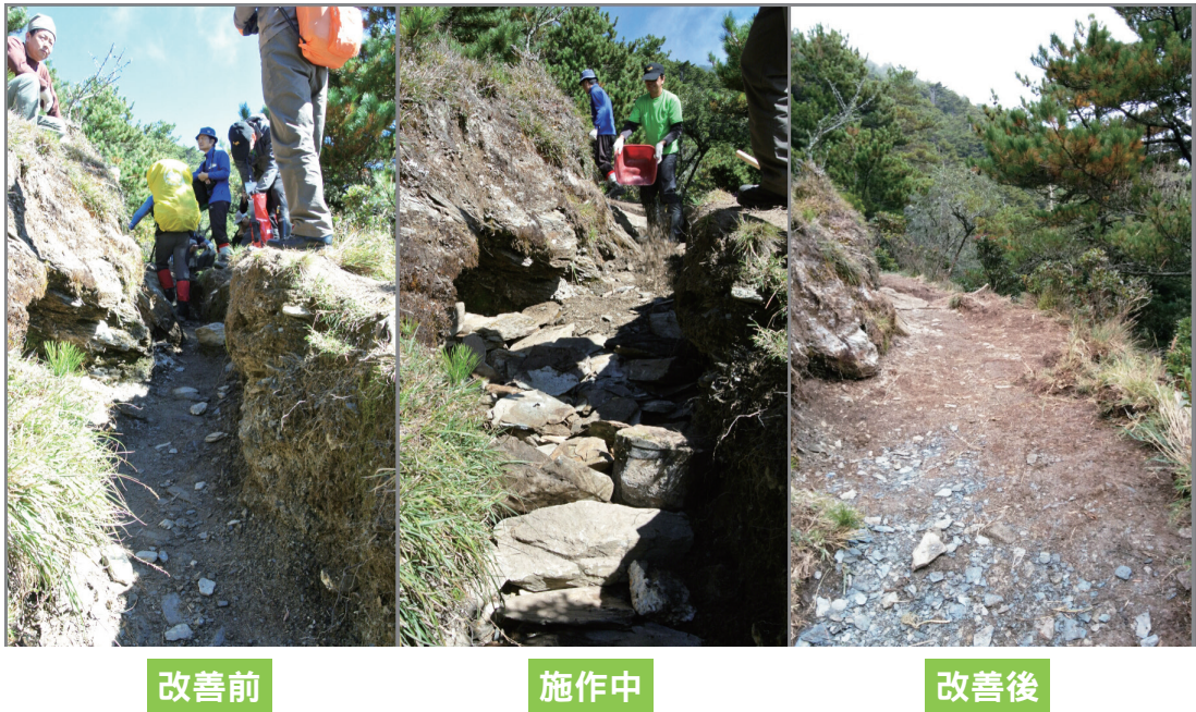
▲圖8、嘉明湖步道沖蝕溝嚴重，經手作回填改善後，與環境融合。
