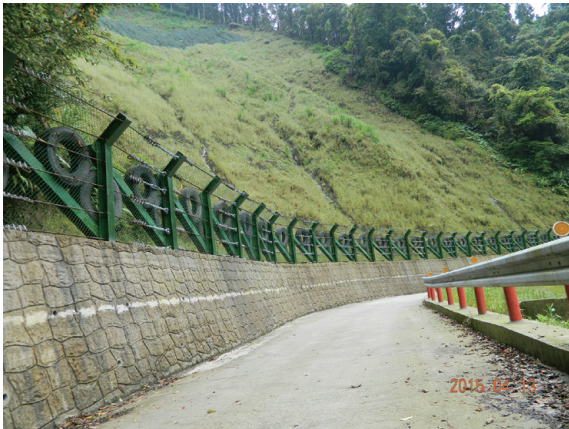
▲「桶後林道3K崩場地處理工程」完工後坡面植生復育良好、綠意盎然，達到景觀生態之效益，擋土牆配合道路曲線施工，線形優美，嚴格管控工程品質。（攝影／新竹林區管理處 蕭國暉）
