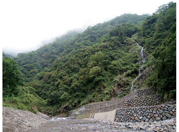
▲工程完工全景（攝影／嘉義林區管理處 洪凱元）
