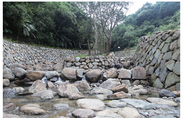
▲「三峽區中崙橋上游河道整治工程」以在地石材為材料砌為護岸及固床工且線型平順，另保留原有樹島(生態島)自然生物棲息環境，藉以串聯溪流兩岸生態棲地環境。(攝影/新竹林區管理處 吳雲瑞)
