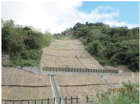
▲銅礦一號橋崩場地整治二期工程為延續前期治理成效，加強崩塌坡面截水、分流，並配合下邊坡豎井及縱溝安全導、排水，符合節能減碳政策，減少混凝土用量，利用噴植植生與苗木栽植加速崩塌坡面植生覆蓋率。（攝影／臺東林區管理處 蘇志凌）
