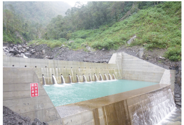
▲此為防砂壩側面照片，照片中上游為防砂壩（主壩），中間為消能靜水池，最下游為防砂壩（副壩）。（攝影／羅東林區管理處 黃至用）
