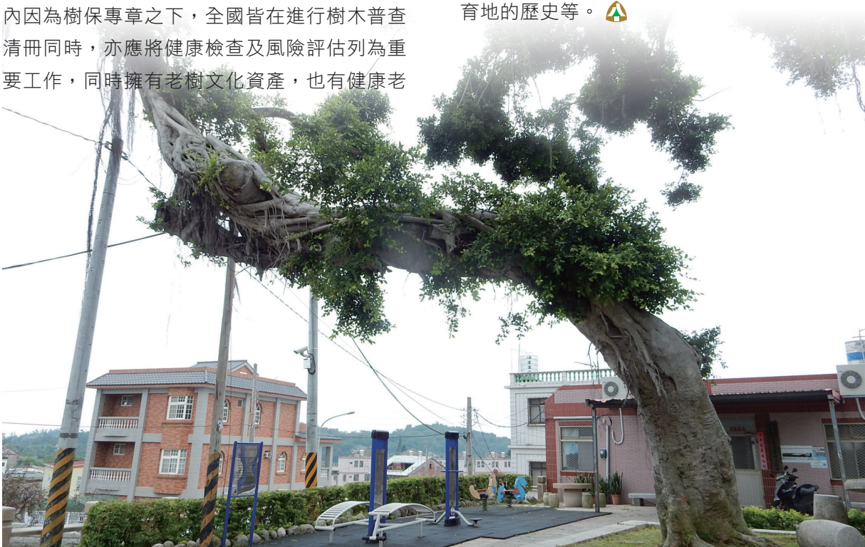
樹木風險評估過程中，除了估算樹木本身塌壞之可能性，亦需考慮標的物存在與否及位置。如本圖中老樹下方有兒童遊憩區，將增加樹木風險等級。
