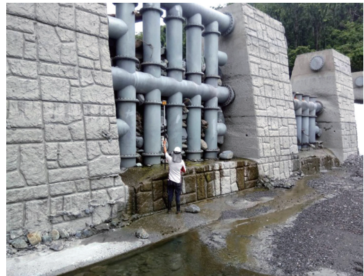
圖4、知本溪可調式防砂壩淤積情形。
