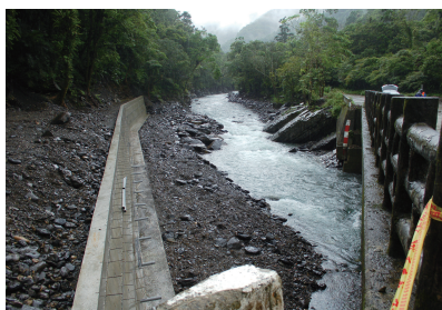
圖3、構築混凝土擋土牆。
