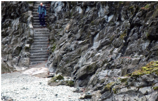
圖1、善德護岸，1996年規劃至2002年完工，仿岩造型模板面積約5,600平方公尺，造價約13億日圓（約3.64億台幣）。
