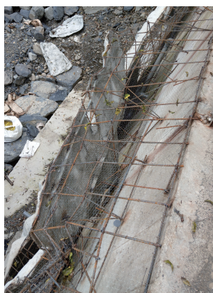
圖7、組立仿岩造型模板，連結混凝土擋土牆預留筋。
