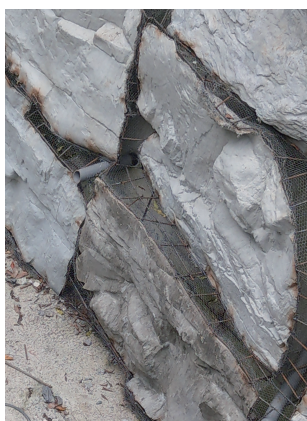
圖6、組立仿岩造型模板，延伸排水管出口。
