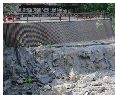
圖14、仿岩造型模版再植生後情形。
