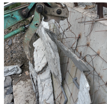
圖5、組立仿岩造型模板。
