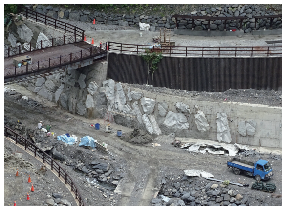
圖8、組立仿岩造型模板。
