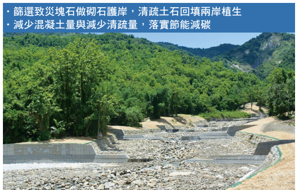
圖5、以溪中塊石，砌築護岸。
