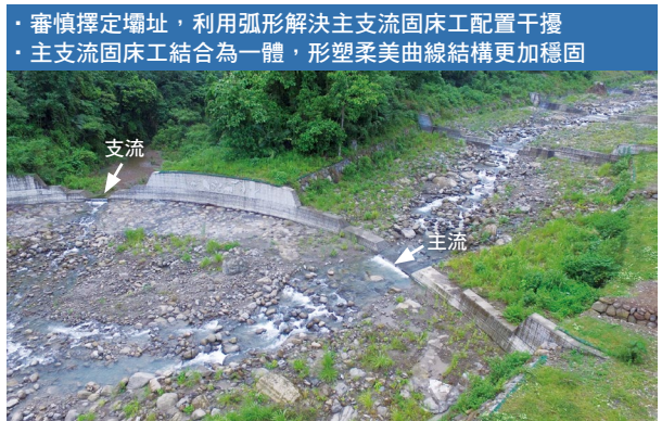
圖4、弧形固床工控制流心減緩冲刷。
