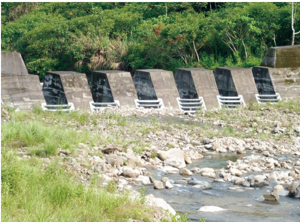
圖24、淤積已達鋼管指標。
