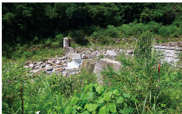
圖13、溪床緩坡化，利於生物溯游。
