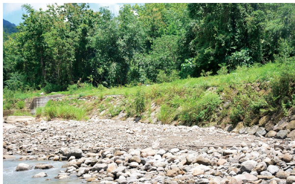
圖11、緩坡化護岸，供濱溪生物往來。
