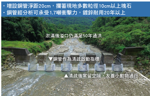
圖6、增設鋼管加密，提升攔阻效益。
