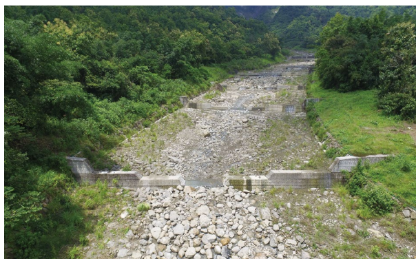
圖12、低矮固床工，確保縱向生態廊道。
