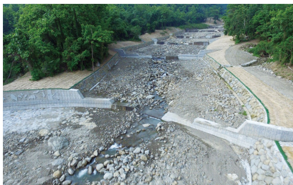
圖20、邊坡鋪蓋稻草蓆及撒播草籽。
