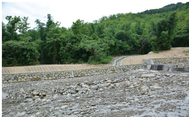
圖10、階梯式親水護岸，維持生態廊道。
