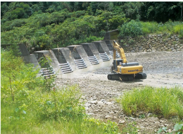
圖26、清疏作業施工。
