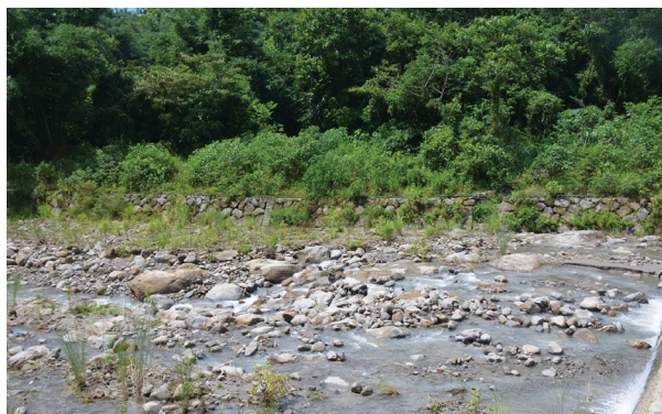
圖15、護岸孔隙，有利日後植物著生。
