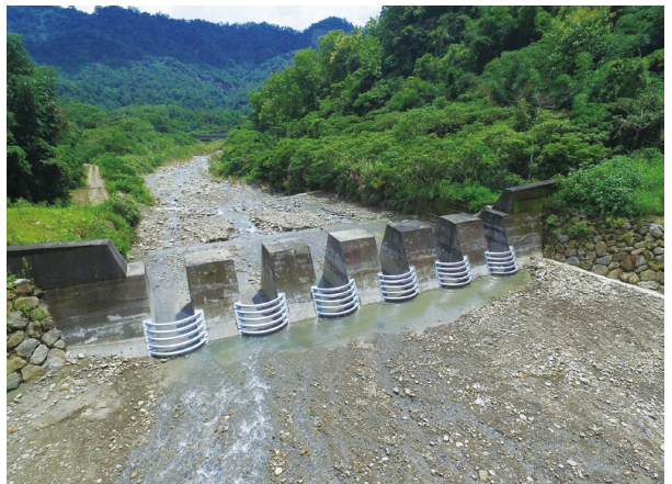
圖27、清疏作業完成。
