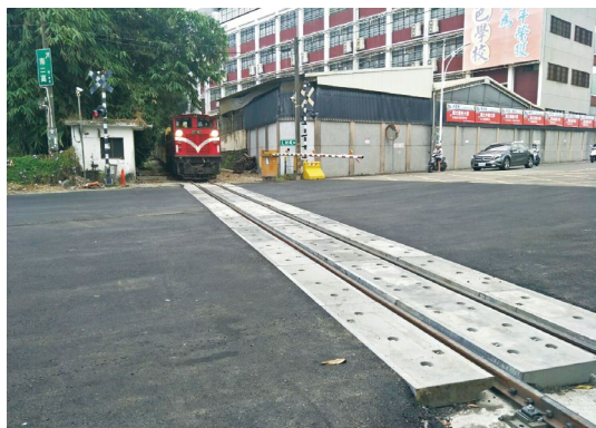
博東路平交道改善完成進行列車試運轉。(攝影/林鐵及文資處 沈宜慶)
