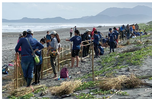
守護宜蘭海岸線，百位師生齊心手做，為保安林擋風遮砂。(攝影/羅東林區管理處 翁儷真)
