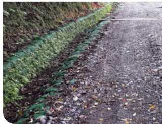
⑫ 林道內側集排水設施低矮化、緩坡化、增加透水性
