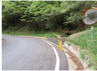
⑫ 林道內側集排水設施低矮化、緩坡化、增加透水性
