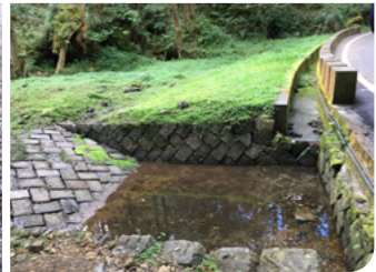
⑫ 林道內側集排水設施低矮化、緩坡化、增加透水性
