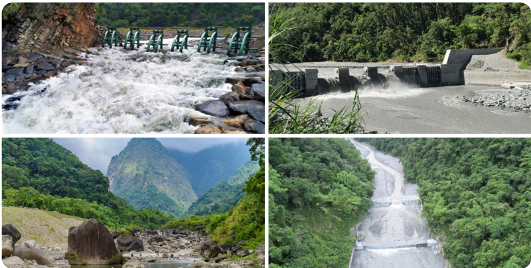
⑭ 臺南玉井區孛仔寮坑野溪友善通道動物利用情形 ⑮ 臺南玉井區平坑溪保留自然通道及設置動物通道，調查過程亦留意溪床活動蹤跡。 ⑯ 南投加走寮溪兩側護岸動物於溪床活動蹤跡 ⑰ 溪流縱向友善措施案例 ⒶⒷ 透過性鋼管壩並保留低水流路 Ⓒ 低矮化構造適當間距開口與保留河床巨石 Ⓓ 既有壩體降控
