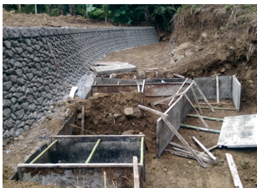
混凝土護岸及固床工
