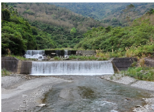
混凝土工程攔砂壩
