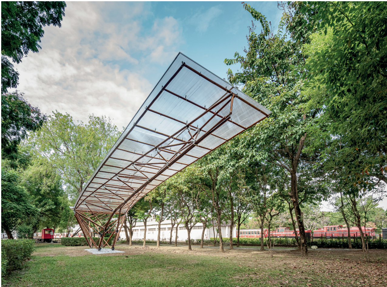
■ 阿里山林業鐵路，北門站 | 15m 竹結構懸臂系統 | 懸臂桁架系統 + 不銹鋼五金 JOINT
