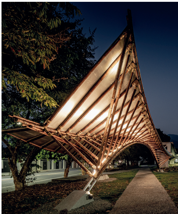
阿里山林業鐵路，竹崎車站 | 連續漸變立體多重拱形結構 | 凹形卡扣螺栓 JOINT
