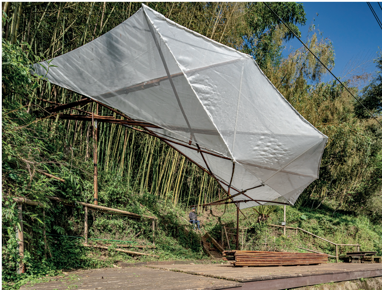
■ 阿里山林業鐵路，北門站 | 6m 竹結構薄殼系統 | 竹片卡扣摩擦接合 + 局部螺栓接合（接地處）
