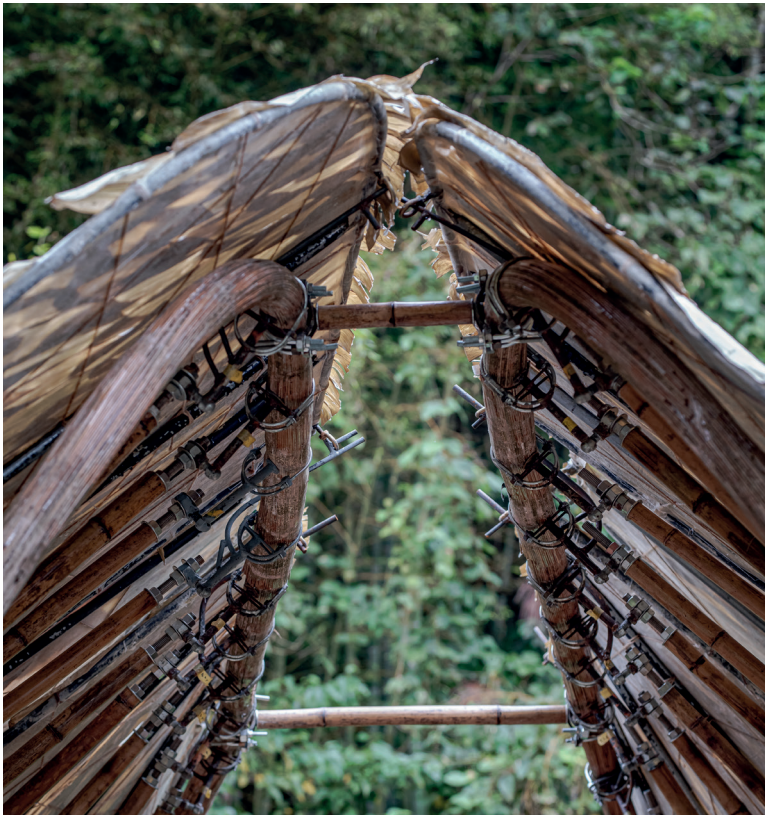
■ 阿里山林業鐵路，水社寮車站 | 拱形彎曲形抗結構 | 集束竹一體成形 JOINT
