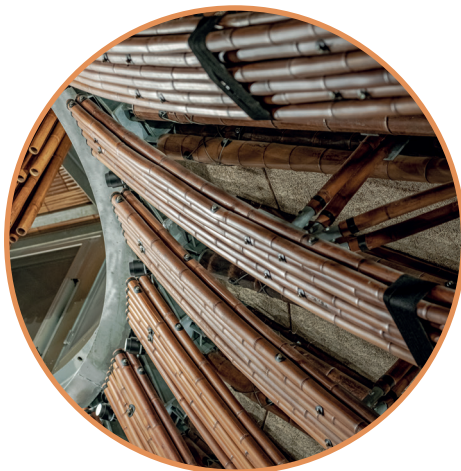
彎下弦不只為了漂亮，原型結構工程顧問陳冠帆解釋，彎曲帶有懸垂且受拉的意涵，也表達了力量。有如拋物線的下弦，即是受拉力的自然線條。
