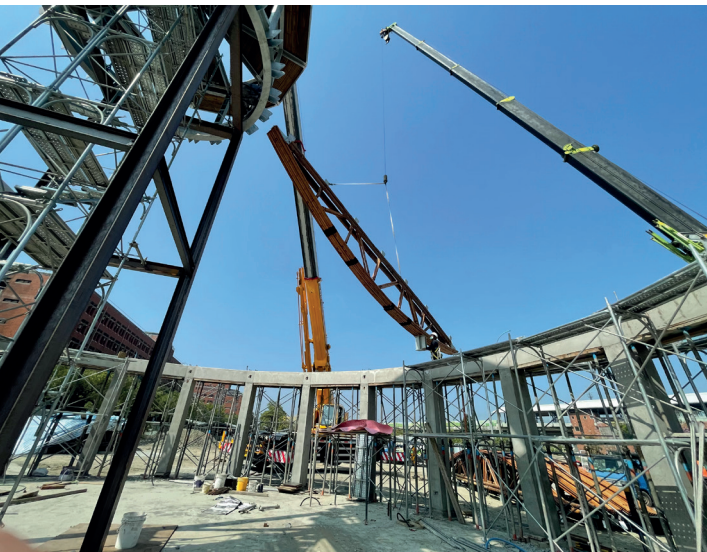
■ 竹構在我國雖尚未有建築法規、技術規範可參考，但經過建築人的大膽挑戰與耐心實驗，確認一組竹桁架可承重5公噸，使後續能順利施工。
