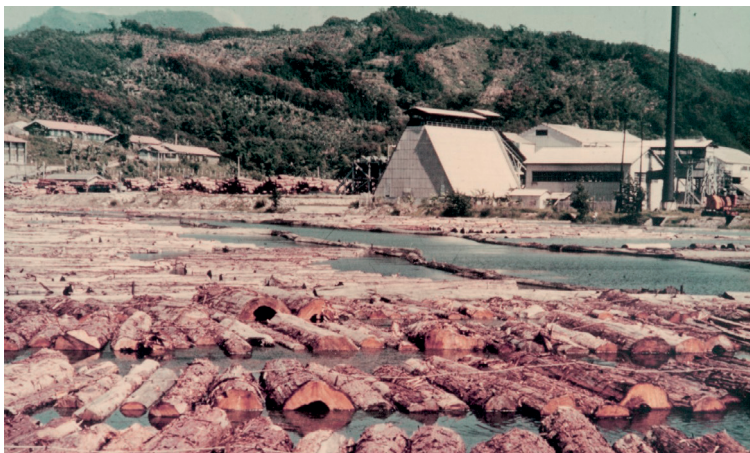
■ 大雪山林業公司的貯木池、燃料倉、鍋爐間、切片倉與大製材廠。（照片出處 / 《大雪山林業史話》封面）
