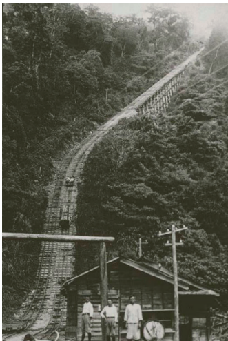
■ 八仙山林場伏地索道（照片出處／《八仙山林場史話》封面）
