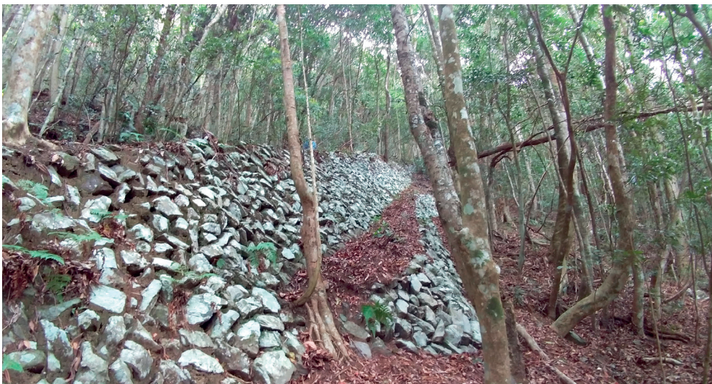
■ 八仙山林場伏地索道第 1 段砌石路基現況，接近斜頭角。
