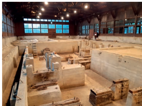
2017 年開挖出來第二代製材工場內的地下遺構
