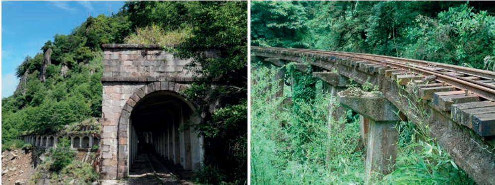
鐵道與橋梁、隧道之修復與部分原貌復原應可作為高山鐵道之生活博物館。
