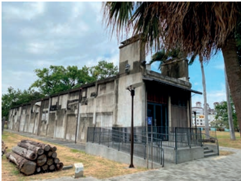
■ 混凝土式的乾燥室可乾燥更多的木材
