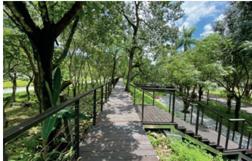
■ 新築的堤頂棧道，讓原本是分隔林與水的一堵擋牆，成了園區最美麗的觀景眺望長廊。
