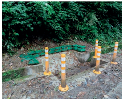
■ 側邊 U 溝增設動物逃生通道
