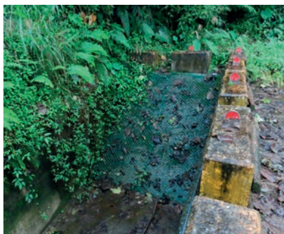
■ 14K+164 集水井左側掛設菱形網
