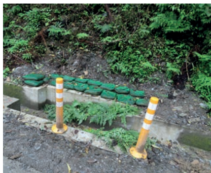
■ 側邊 U 溝增設動物逃生通道
