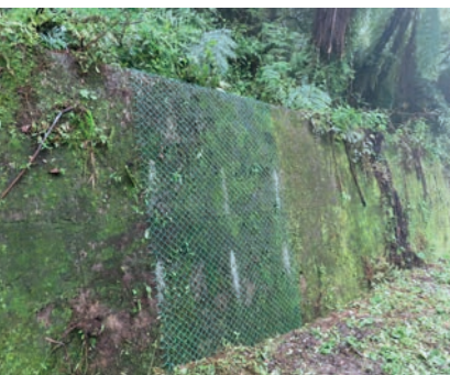
■ 10K+384 上邊坡擋土牆外菱形網
