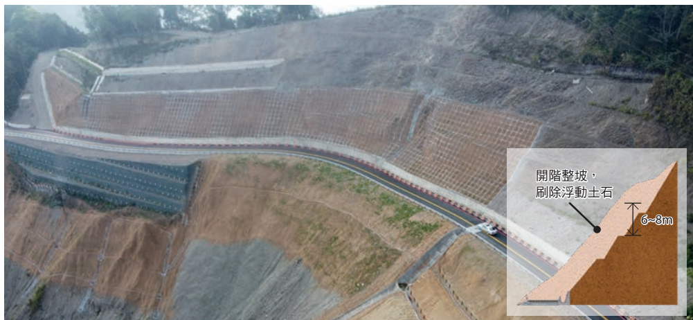
■ 藤枝 18K 周邊路段第一期整治配置（上圖）與 2021 年 5 月工地現況（下圖）
