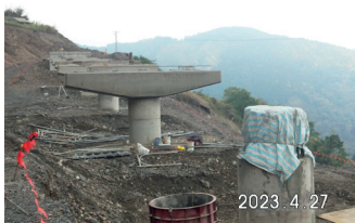
■ 藤枝 18.2K 橋梁工程之基樁、橋墩、鋼梁與橋面施工
