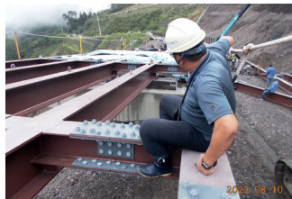
■ 藤枝 18.2K 橋梁工程之基樁、橋墩、鋼梁與橋面施工
