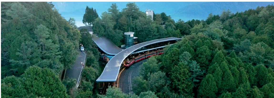
祝山車站的雲浪造型屋頂利用車站自然的地形坡度，從月臺、車站前廳、階梯通道延伸至觀日涼亭，仿若雲海瀾漫山谷，交織成雲頂上最美的車站。（攝影／阿里山林業鐵路及文化資產管理處 吳明翰）
