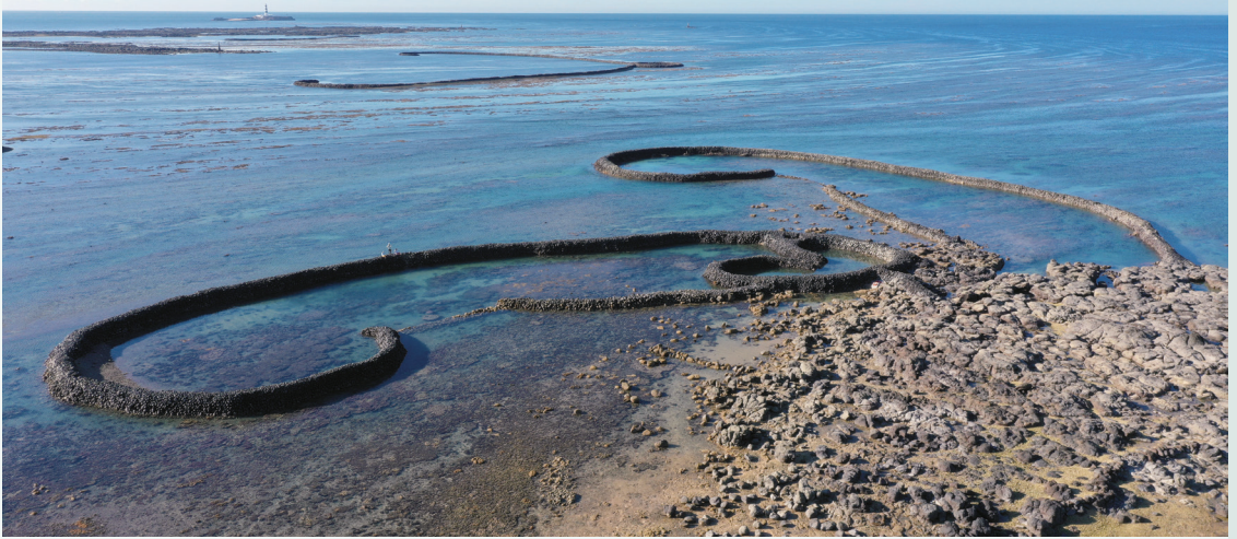
■ 吉貝嶼瀨仔滬是一口弧形滬（圖右）、白沙仔滬是一口單滬房石滬（圖左）。
