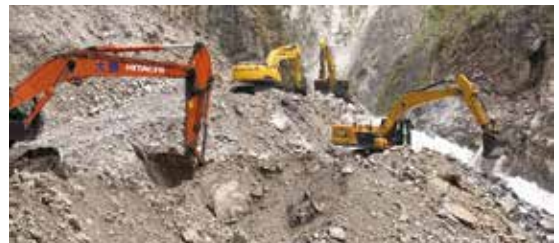
壩體降挖與導流情形（林業保育署宜蘭分署提供）
