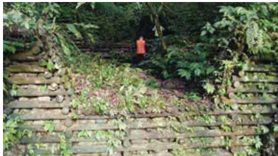
■ 宜專一線 2.5K 木構節制壩 2025 年現況
