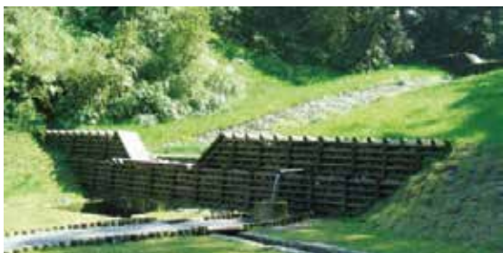
■ 宜專一線 16K 木構節制壩 2006 年施工完成（昆管實業股份有限公司提供）
