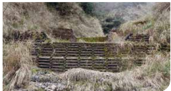
■ 宜專一線 24.5K 木構節制壩 2025 年現況
