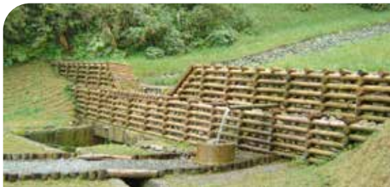
■ 2006 年的宜專一線 16.5K 木構節制壩（昆晉實業股份有限公司提供）
