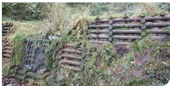
■ 宜專一線 16K 木構節制壩 2025 年現況
