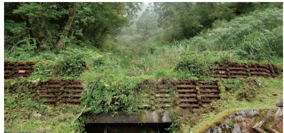
■ 宜專一線 16.5K 木構節制壩 2025 年現況
