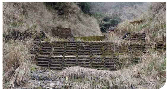
■ 宜專一線 24.5K 木構節制壩 2025 年現況
