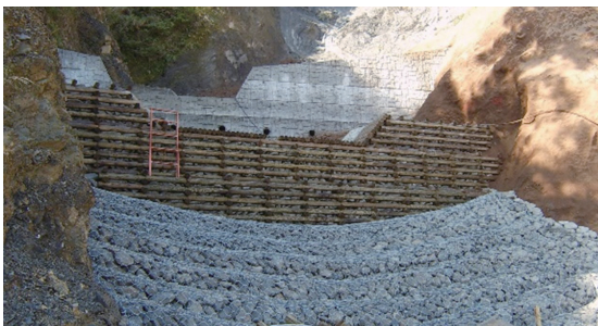
■ 宜專一線 24.5K 木構節制壩 2006 年施工完成（林信輝，2012）
