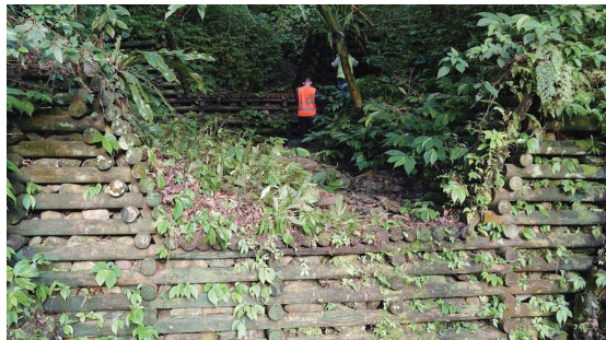
■ 宜專一線 2.5K 木構節制壩 2025 年現況
