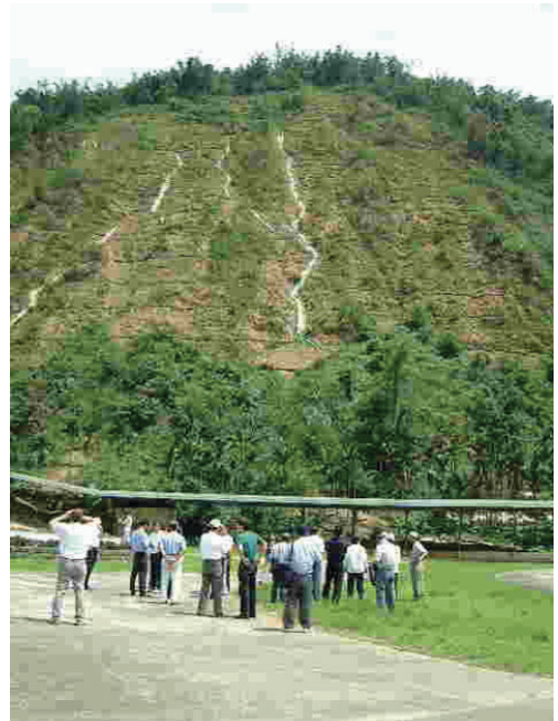
(上)水里興隆中坑源頭處理 (中)埔里97林班源頭處理 (下)龍泉南坑左右護岸工程
