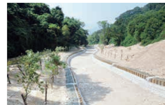
▲南投處—103 年度社頭鄉保安林野溪整治工程
