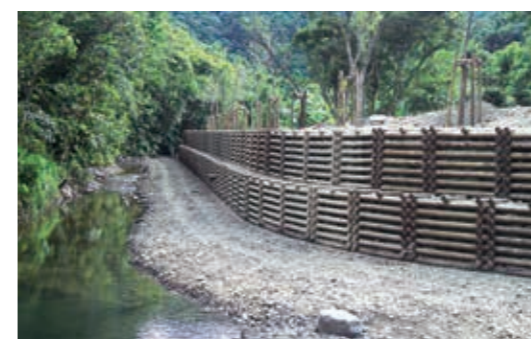
▲羅東處—平溪護岸整治工程
