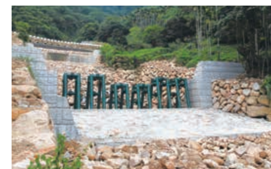
▲南投處—103 年戀大區 6 林班野溪整治工程
