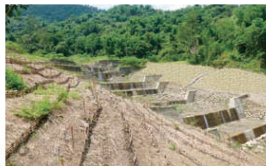
▲102 ~ 103 年度優良農建獎－嘉義處－玉井區第 69 林班亞美坑崩塌地整治二期工程
