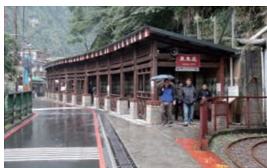
▲烏來台車瀑布站屋頂改善工程
