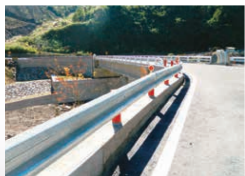
▲新竹處—大鹿林道大鹿林道土場橋完工後（新竹縣五峰鄉）
