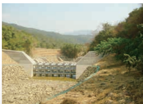
▲屏東處—加都魯溪土砂防治一期工程（屏東縣滿州鄉）
