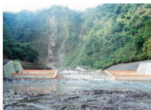
▲羅東處—鳩之澤一號潛壩修復工程（宜蘭縣大同鄉）
