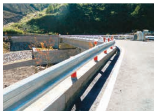
▲新竹處—大鹿林道大鹿林道土場橋完工後（新竹縣五峰鄉）
