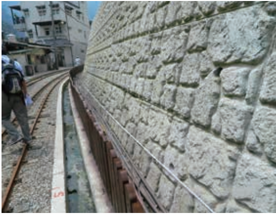
▲烏來台車軌道沿線護坡改善工程
