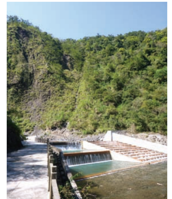
▲羅東處－多望溪鳩之潭段整體治理第三期工程
