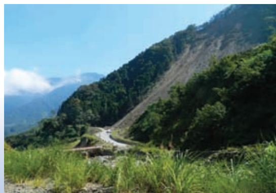
▲新竹處－大鹿林道1K+500崩塌緊急處理災害後處理情形
