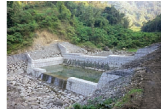
▲嘉義處－大埔區94林班野溪整治工程
