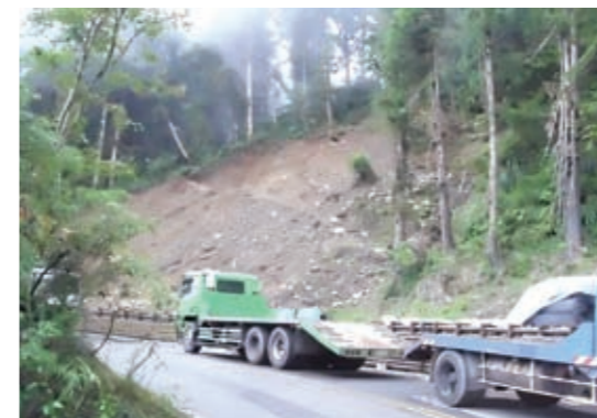
▲羅東處－宜專一線路面及路基改善工程改善前情形
