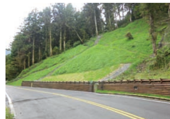
▲羅東處－宜專一線路面及路基改善工程改善後情形
