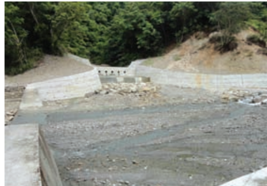
▲花蓮處－玉區83林班坡腳穩固工程
