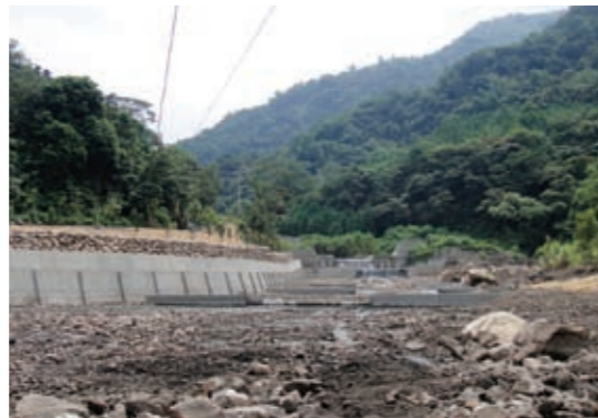
▲南投處－埔里區26林班野溪整治加強工程
