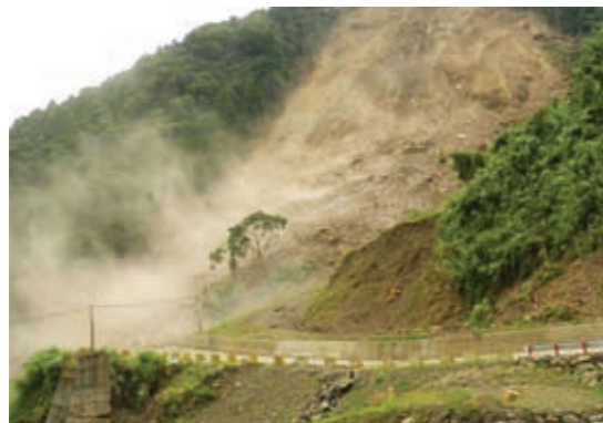
▲新竹處－大鹿林道1K+500崩塌緊急處理災害時情形
