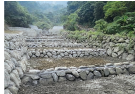
▲嘉義處－三重溪橋上下游整治工程
