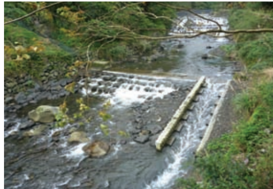
▲101年度金質獎－新竹處－蚵仔溪護岸延長2期工程
