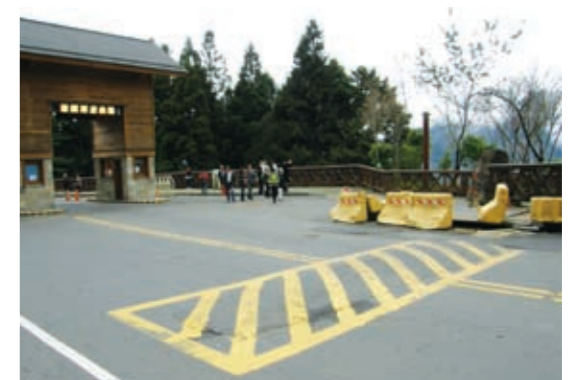
▲嘉義處－祝山林道0K+000遊樂區入口工程改善前情形
