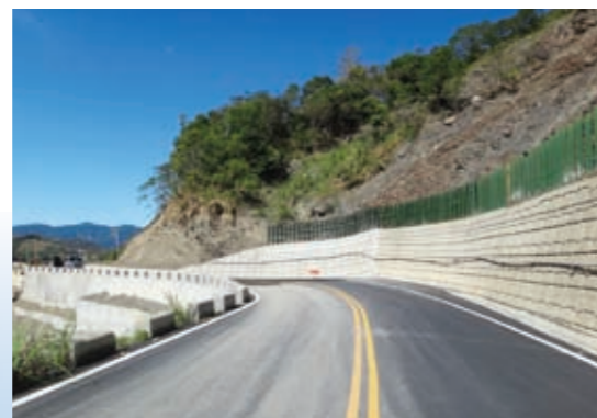
▲南投處－奧萬大聯外道路7K+000工程改善後情形
