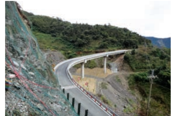
▲屏東處－寶山一號橋「藤枝林道寶山橋新建工程」
