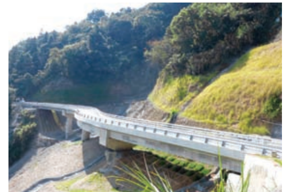
▲屏東處－寶山二號橋「寶山周邊災害復建工程」
