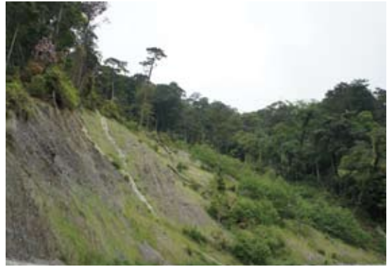
▲崩塌地覆蓋植草網及撒播種子復育造林
