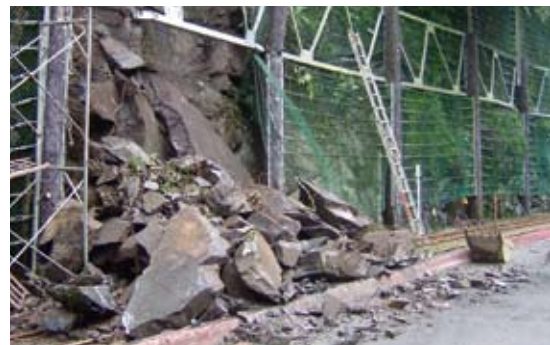
▲烏來台車1K+360軌道上邊坡搶修工程
