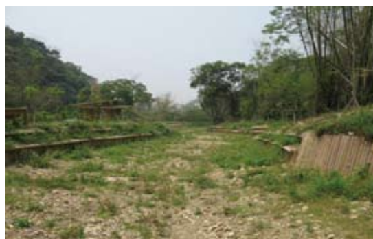
▲南投處一合和集水區上游野溪整治工程／許文奕 攝
