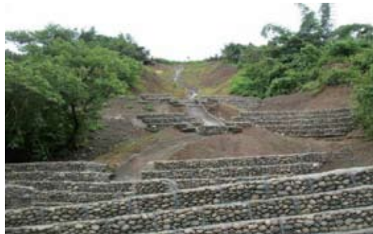
▲屏東處一旗山39林班崩場地處理工程／陳二銘 攝
