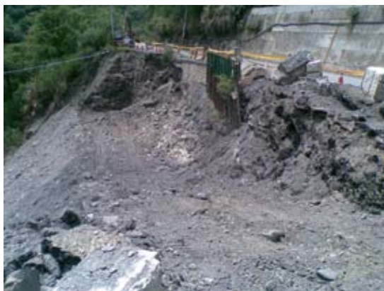
▲奧萬大聯外道路7K+480路基改善工程改善前情形／鄭建志 攝
