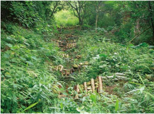
▲新竹林區管理處泰山鄉泰林路二段579巷崩塌地復育工程／吳子健 攝
