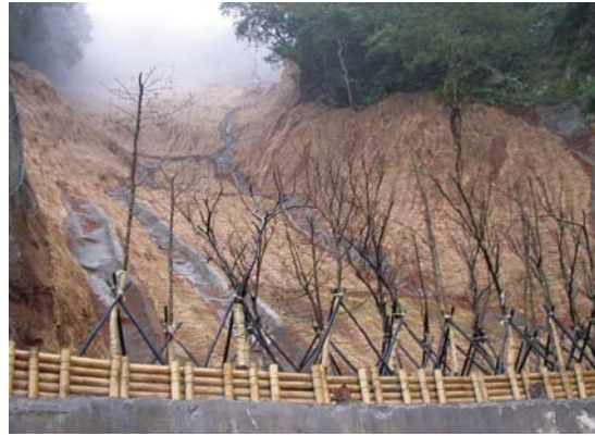
▲97年度石門水庫及其集水區治理計畫大溪事業區第43林班3號崩塌地復育工程／張瑞富 攝
