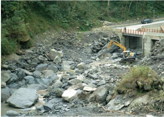
▲大鹿林道9K護岸橋台基礎加固工程改善前情形／林志明 攝
