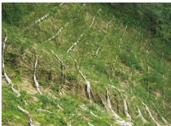
▲南投處巒大事業區88林班崩場地復育
