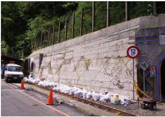
▲隧道外牆改善前
