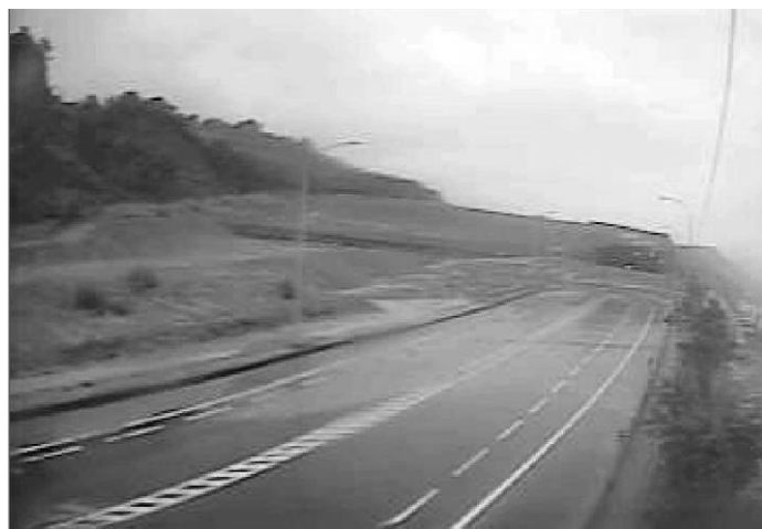
圖 27 風雨逐漸變小，可清楚看到隧道口堆積沙石（8：00 分）
