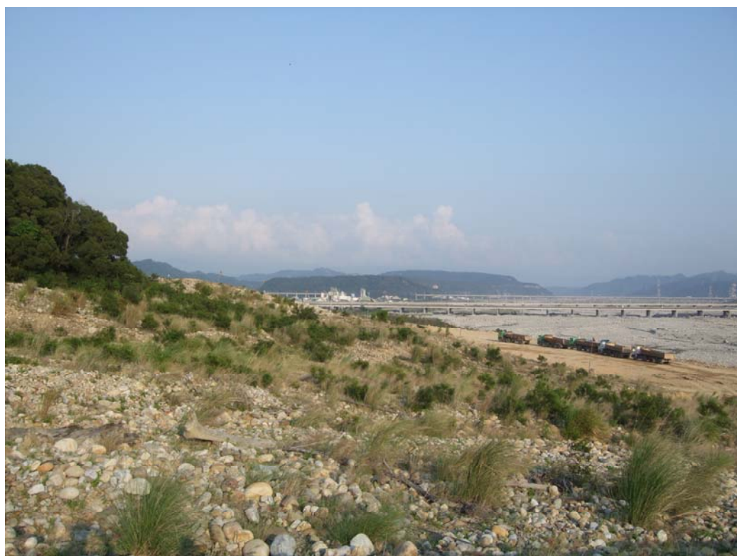
圖 63 三號子集水區沖積扇面，土石挖掘工程正在進行（2008/4/22）
