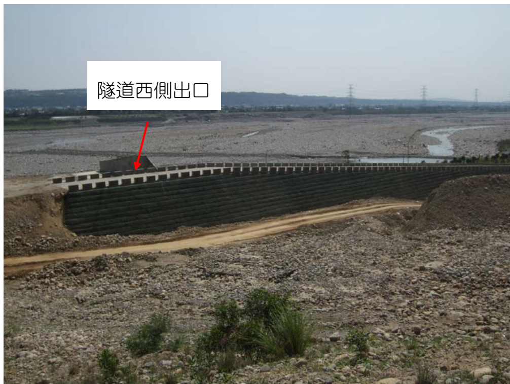
圖 61 隧道西側外的砂石車便道和隧道口（2008/4/22）
