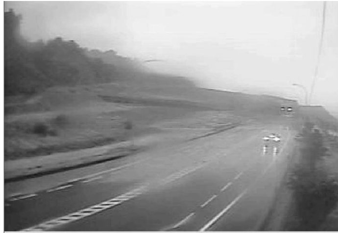
圖 25 泥沙堆積在隧道口，汽車無法通行（6:10 分）
