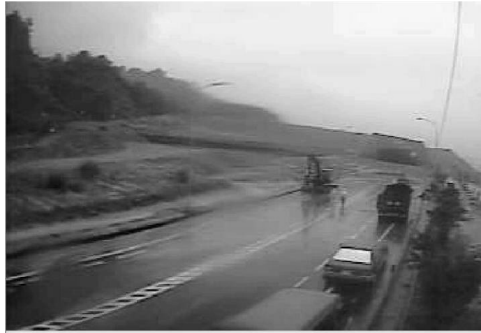
圖 28 挖土機正在清理堆積的沙石（9：50 分）
