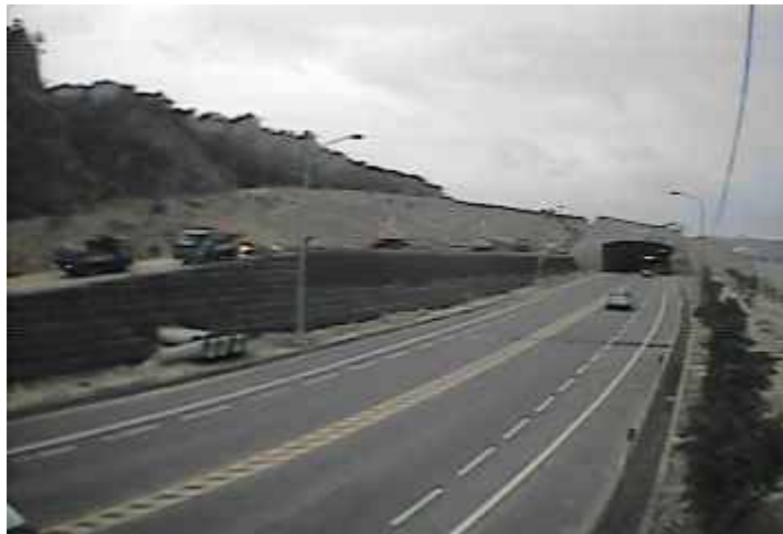
圖 49 隧道西側外沖積扇挖掘工程進行（2008/1/17）
