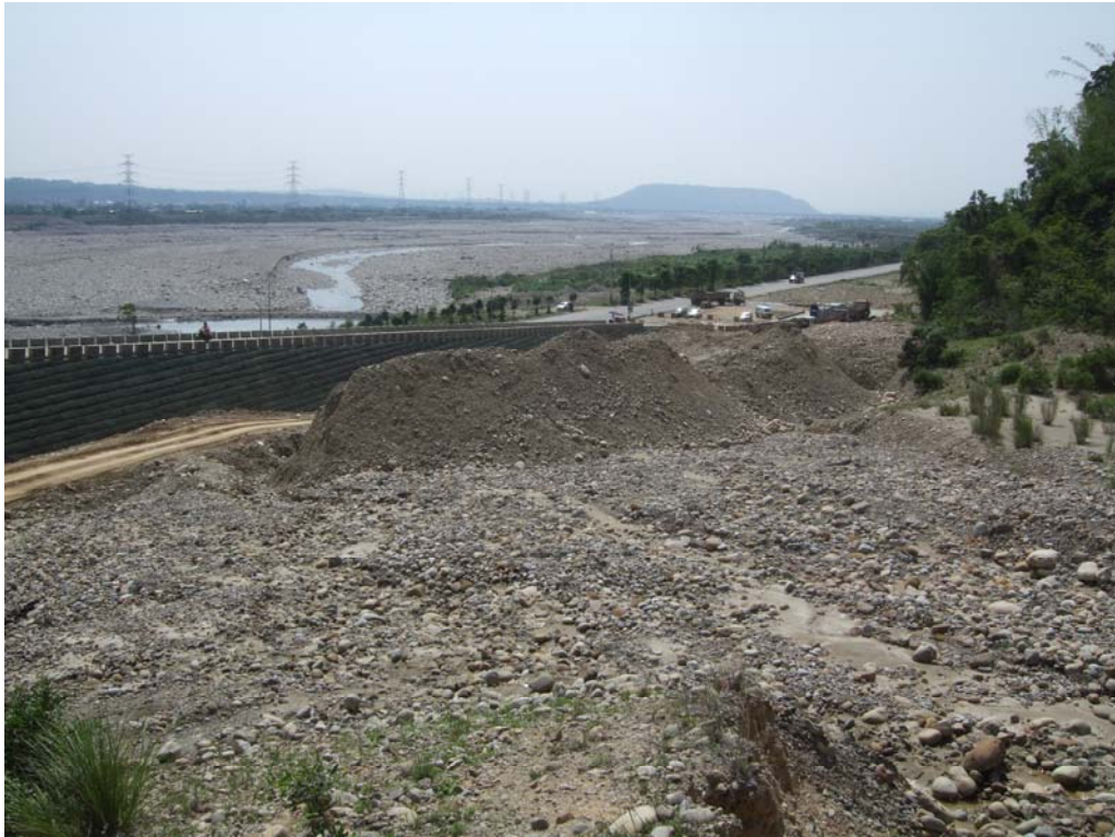
圖 60 隧道西側外的砂石車便道與土石堤（2008/4/22）
