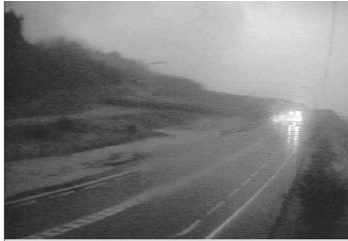
圖 22 隧道前方開始有泥流產生（5：39 分）
