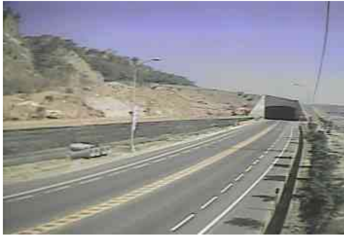
圖 48 隧道西側外沖積扇工程完成（2008/1/11）
