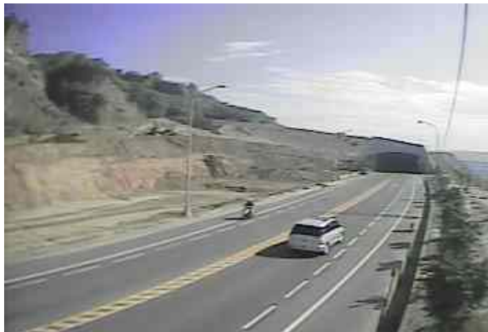
圖 47 隧道西側外沖積扇工程進行情形（2007/12/23）
