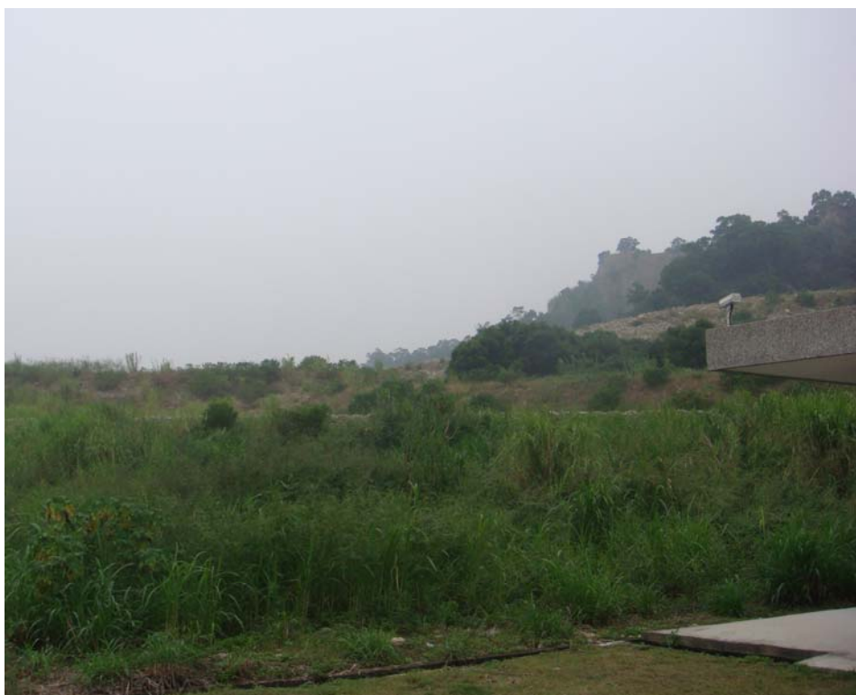
圖 66 2007 年隧道東口處照片（2007.9.19）
