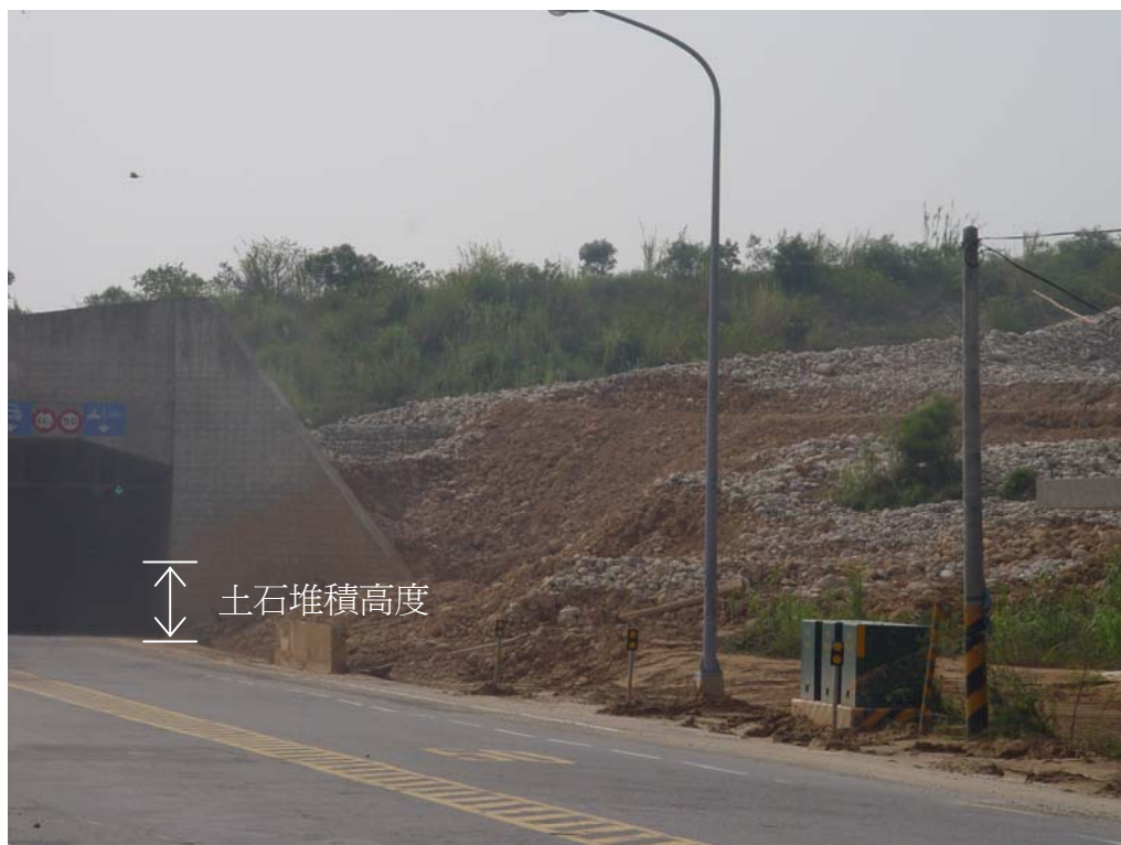
圖 65 辛樂克颱風後隧道東口土石堆積情況（2008.9.19）
