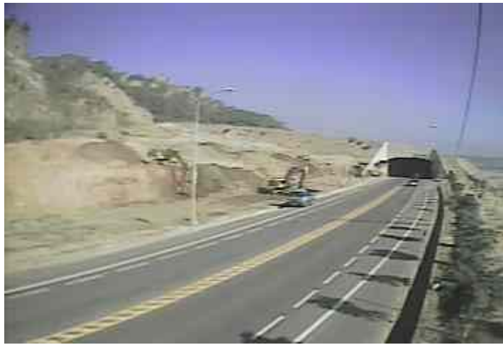
圖 46 隧道西側外沖積扇工程進行情形（2007/12/17）
