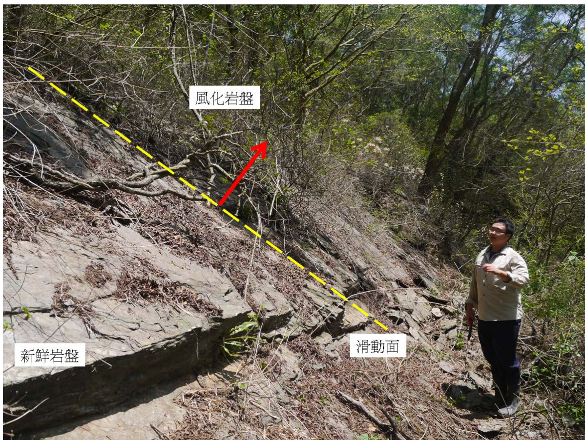
照片 3-4.80、調查點 1 位於坡腹現生崩塌處出露之岩盤。
