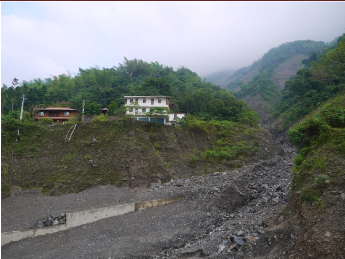
照片 3-4.45、G6-5 崩塌南側土石流，河口寬度 50 公尺，住戶與河床高差 20 公尺。
