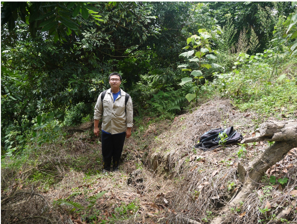
照片 3-4.67、調查點 1 主崩崖內發育之裂隙，落差約 50 公分。
