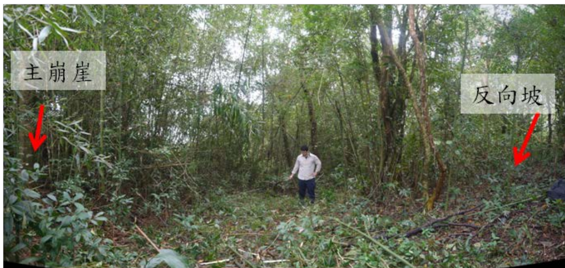
照片 3-4.41、調查點 G6-3 深層崩塌地編號高雄市-六龜區-D015 坡頂的反向坡地形。
