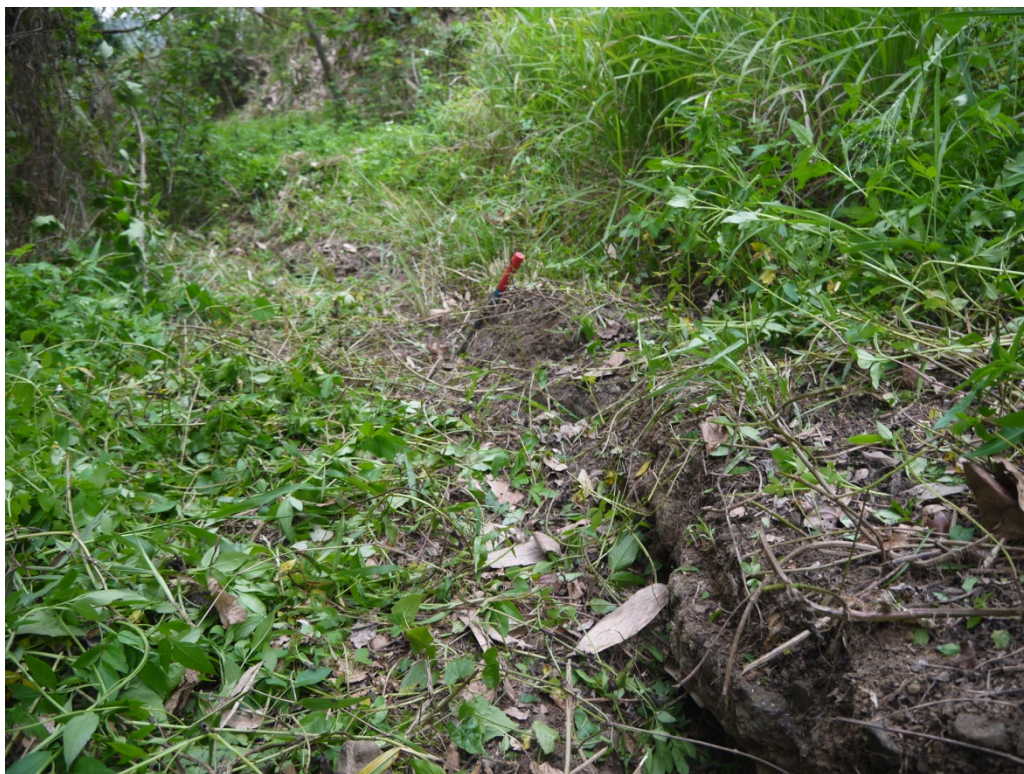
照片 3-4.55、調查點 12 位於南側崩塌坡腹，裂隙高差約 20 到 40 公分不等。
