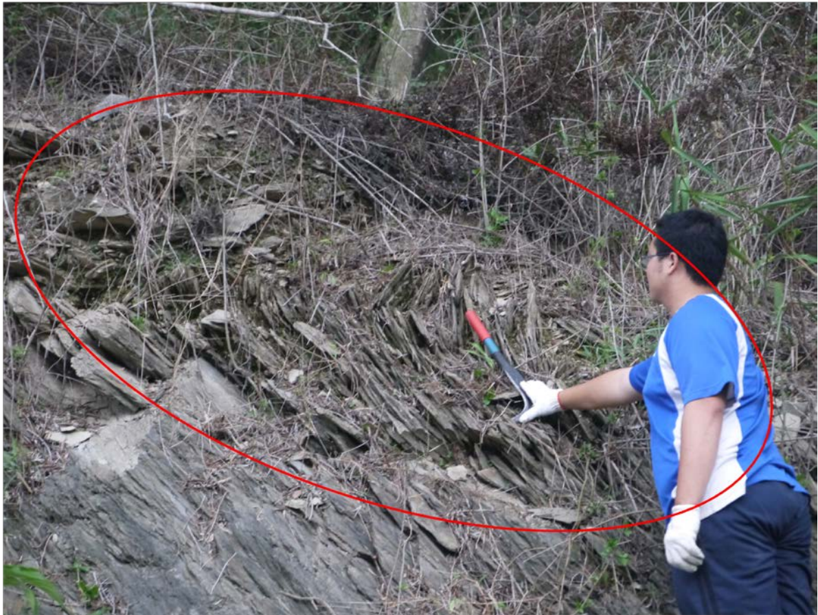
照片 3-4.81、調查點 7 坡面發育重力變形(creeping)。
