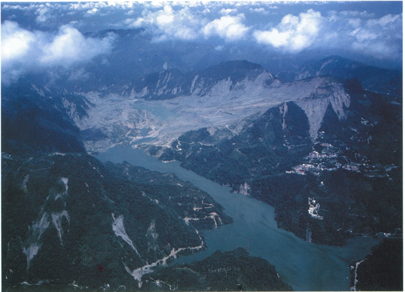
圖 2-4.6、草嶺順向坡平面型破壞照片(地工技術，第 81 期，2000)。
