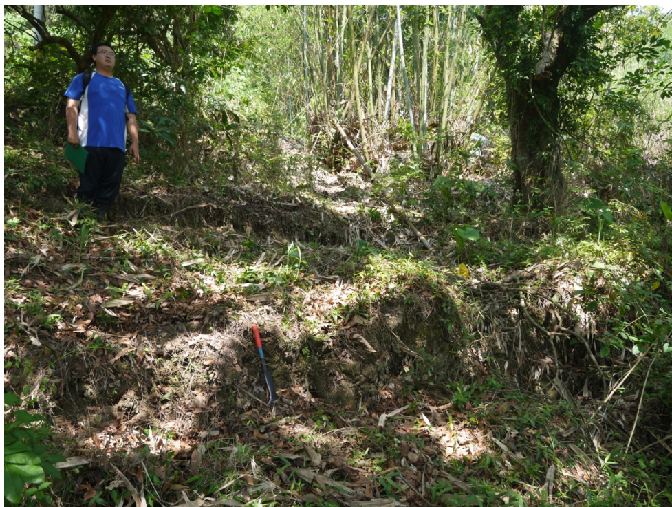
照片 3-4.54、調查點 09 位於南側崩塌坡腹，發育多階裂隙，裂隙高差約 50 到 80 公分不等。
