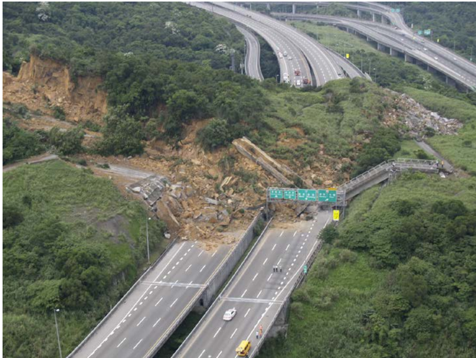
圖 14、平面型破壞深層崩塌案例(國道三號)
