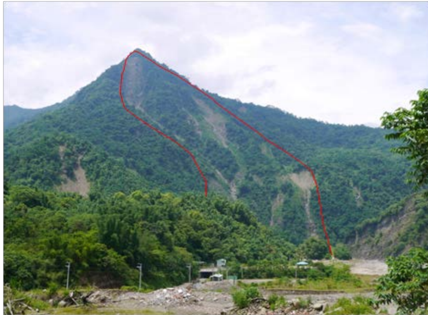
照片 3-2.6、案例八崩塌全景(紅線為判釋之崩塌範圍)。
