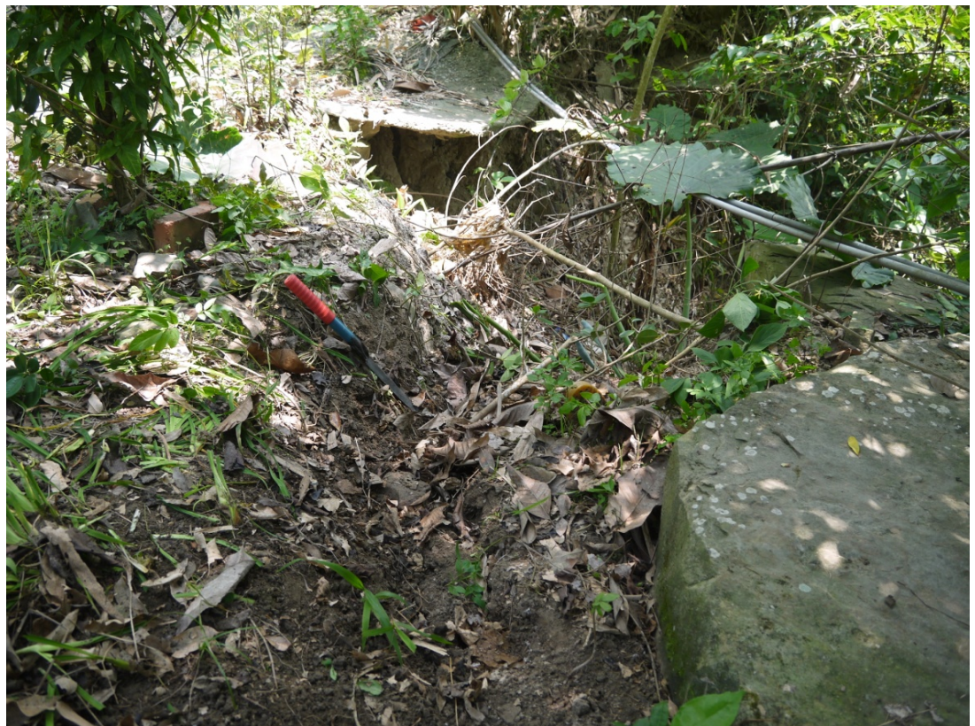
照片 3-4.50、調查點 10 北段崩塌外側崩崖，崩崖位置發育裂隙，顯示此崩崖仍具活動性。
