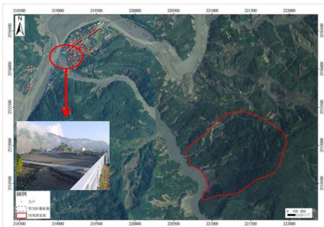
圖 3-10.2、崩塌地編號高雄市-桃源區-D346 崩塌位置與保全住戶相對位置。
