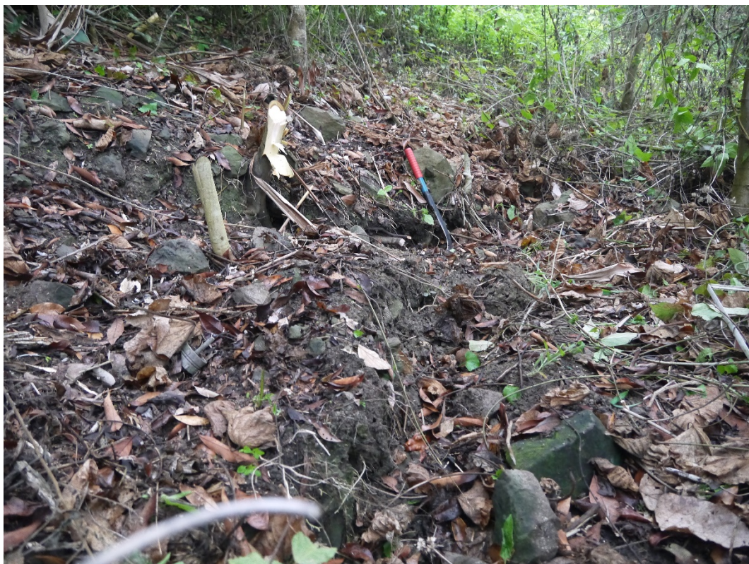
照片 3-4.59、調查點 6 坡腹崩崖及裂隙，落差高度約 0.5 公尺。
