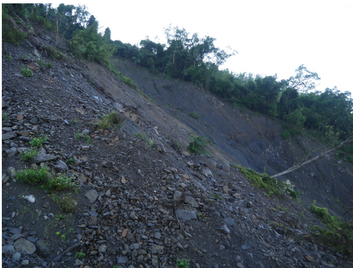
照片 3-4.46、G6-2 為舊崩塌地形，因 0610 豪雨而再次發生崩塌。
