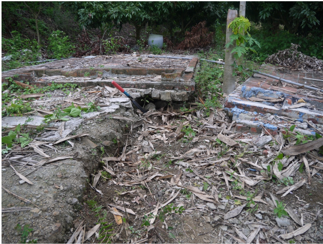
照片 3-4.72、調查點 6 位於坡腹發育裂隙，裂隙高差約 25 公分。
