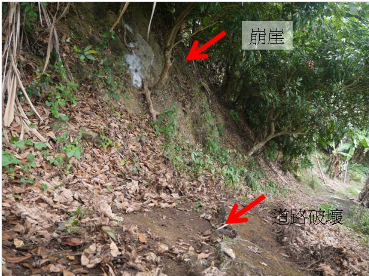
照片 3-4.68、調查點 2 位於主崩崖，主崩崖與路面破壞方向相近。
