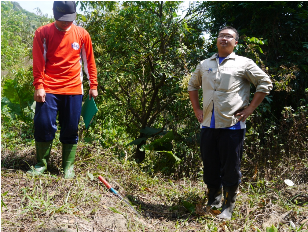
照片 3-4.64、調查點 3 發育一高差約 30 公分的裂隙。
