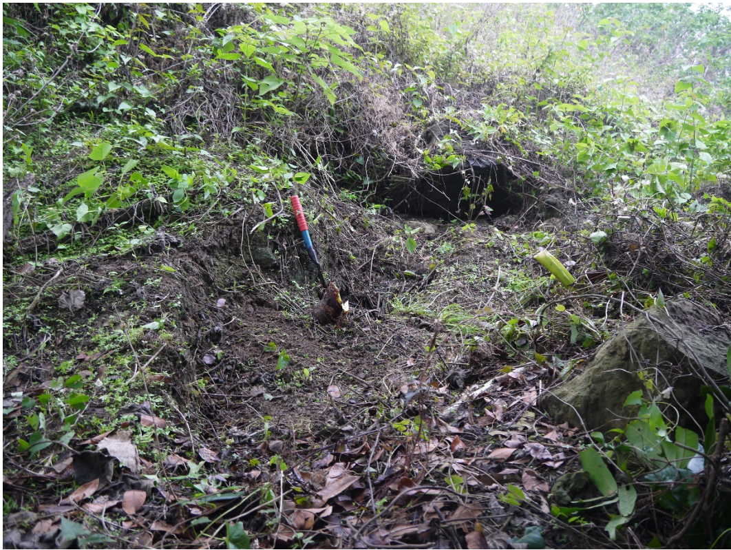
照片 3-4.60、調查點 7 坡腹崩崖及裂隙，落差高度約 0.5 公尺。
