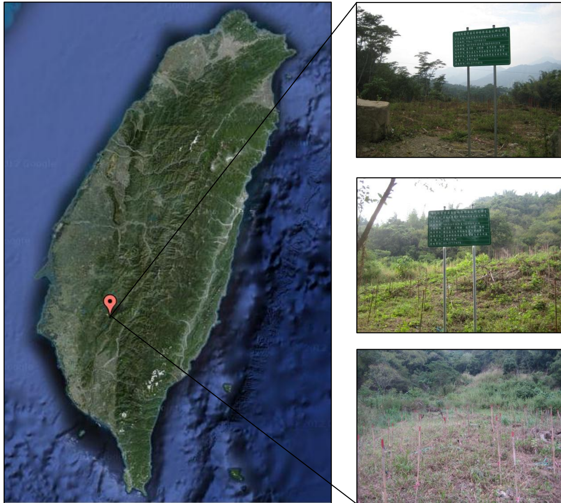
圖 1 玉井事業區 3 處崩塌地之衛星、現場影像
